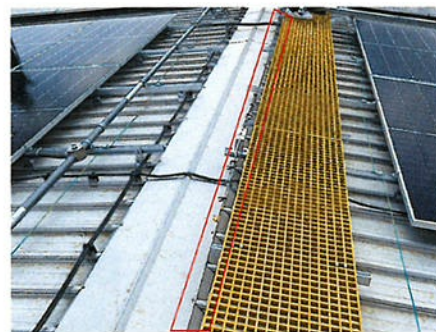
ภาพที่ 2-66 สาย Life Line บริเวณหลังคาอาคาร
