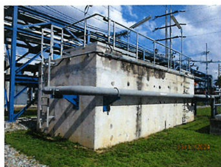
ภาพที่ 2-9 บ่อแยกน้ำ/น้ำมัน (Oil Separator)
