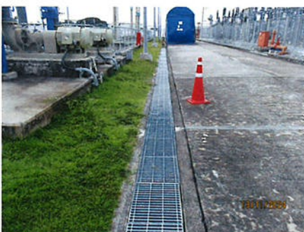
ภาพที่ 2-30 รางระบายน้ำฝนในพื้นที่โครงการ
