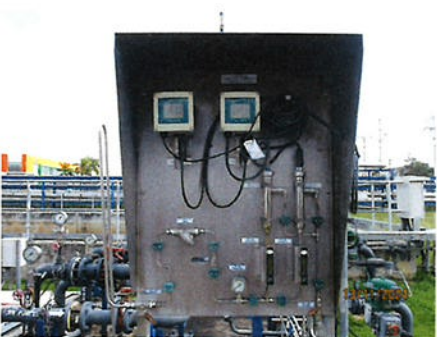
ภาพที่ 2-15 ระบบ Online Monitoring บริเวณบ่อพักน้ำทิ้งรวม
