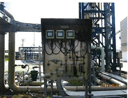
ภาพที่ 2-17 ระบบ Online Monitoring บริเวณบ่อพักน้ำหล่อเย็น
