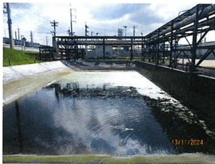
ภาพที่ 2-16 บ่อพักน้ำหล่อเย็น
