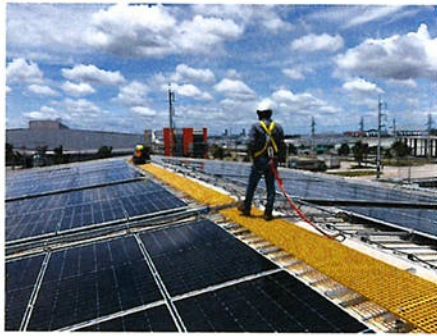
ภาพที่ 2-67 การสวมใส่อุปกรณ์นิรภัยหรือสายช่วยชีวิต
