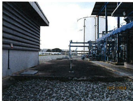
ภาพที่ 2-14 บ่อปรับสภาพความเป็นกรด-ด่าง (Neutralization Pit)
