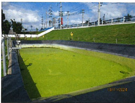
ภาพที่ 2-18 บ่อพักน้ำหล่อเย็น กรณีฉุกเฉิน
